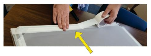
BE SUIRE THE TAPE COVERS THE MESH PAST THE INSIDE OF THE FRAME
